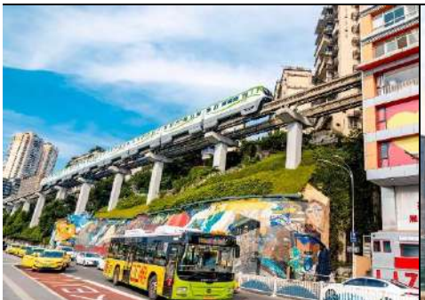
李子坝轻轨穿楼
