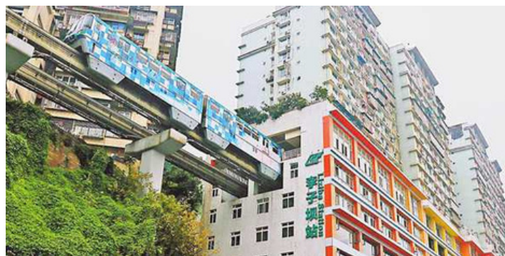
📍 重庆李子坝轻轨穿楼
